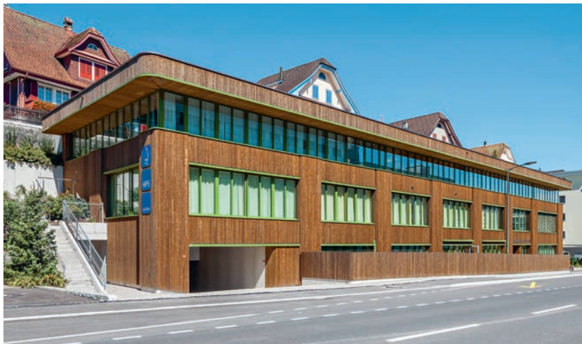
Neubau: Heilpraktikerschule in Ebikon LU Architektur: Unit Architekten AG, Hergiswil LU
