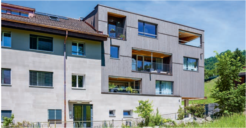
Anbau: Mehrfamilienhaus in Dierikon LU Architektur: Rothenfluh & Partner Architekten, Luzern
